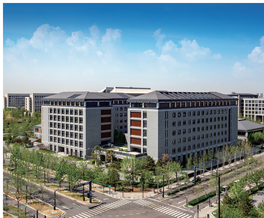
北京城市副中心行政办公区B1、B2工程
