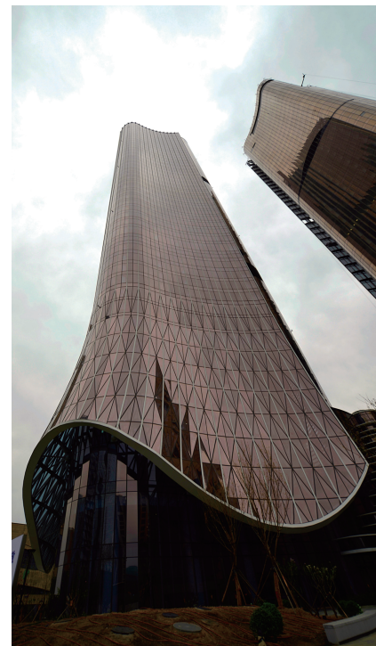
626-1#商业办公楼等3项及地下车库工程
