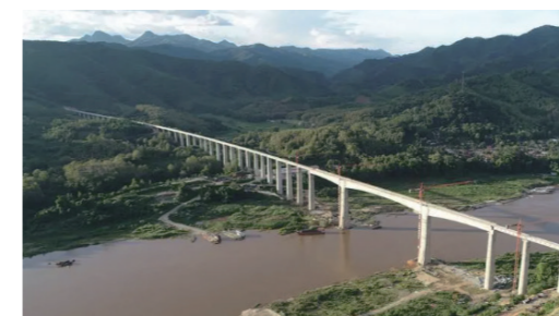
中老铁路班纳汉湄公河特大桥
