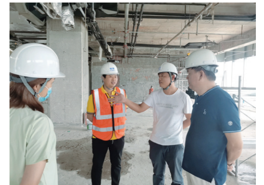
华开大董南新仓项目一线施工现场
