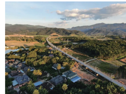
老挝北部拍摄的中老铁路
