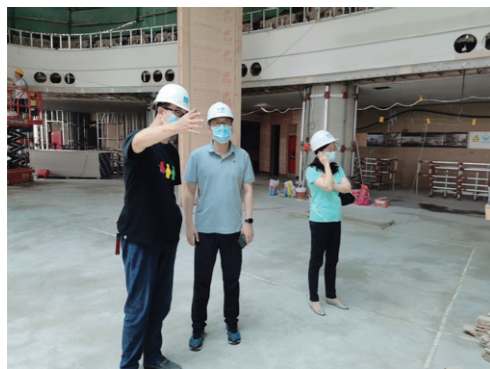
华开港澳中心项目一线施工现场
