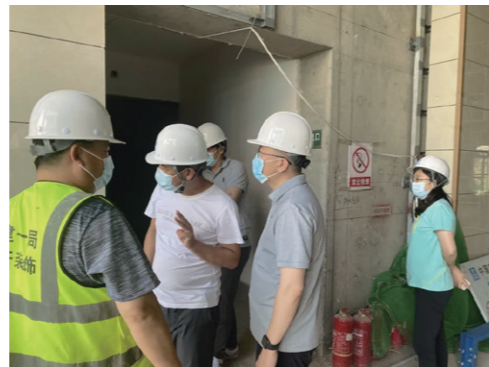
华开北京文化中心项目一线施工现场
